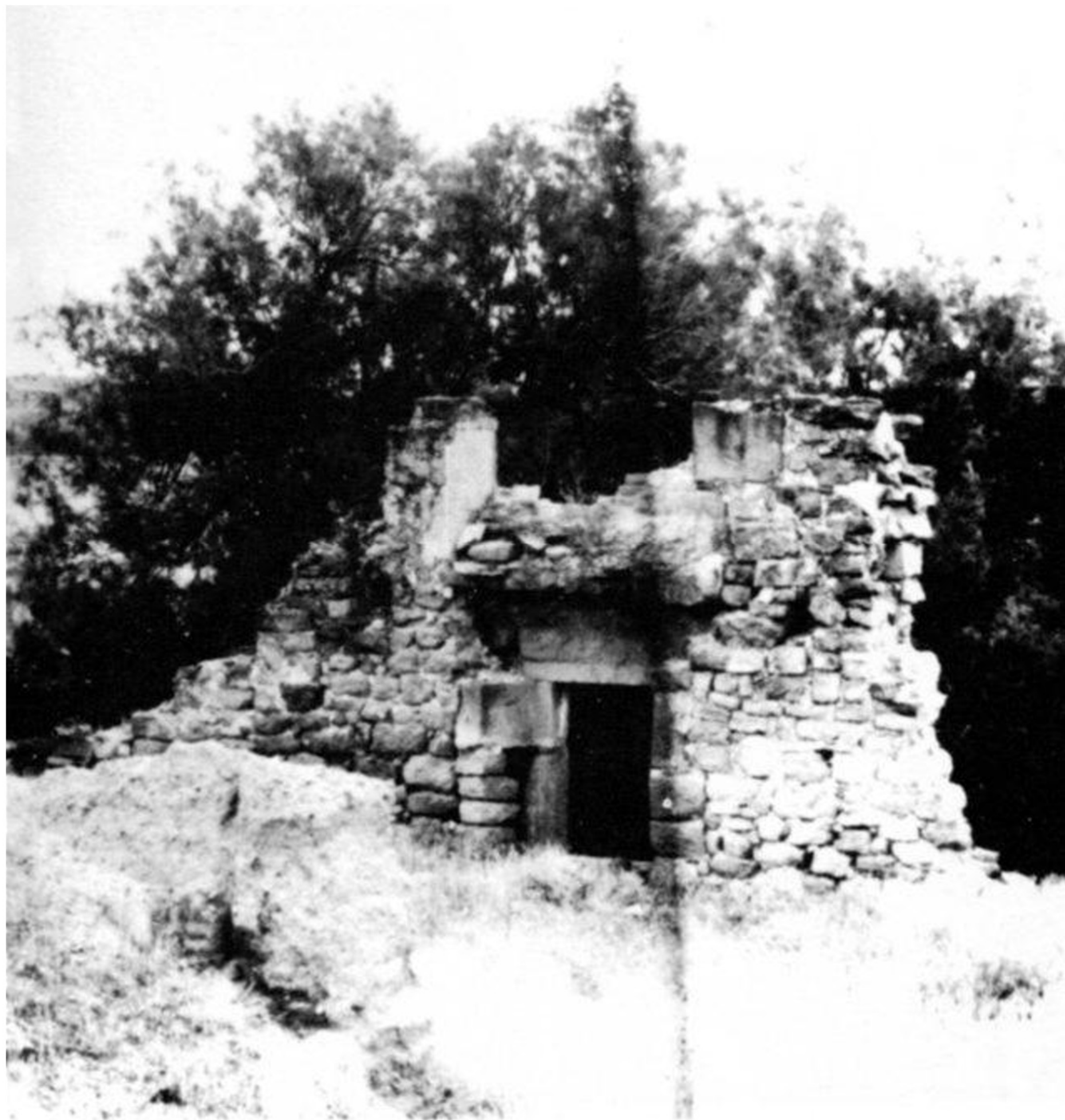
Ruinas de la antigua venta de Murillete.
